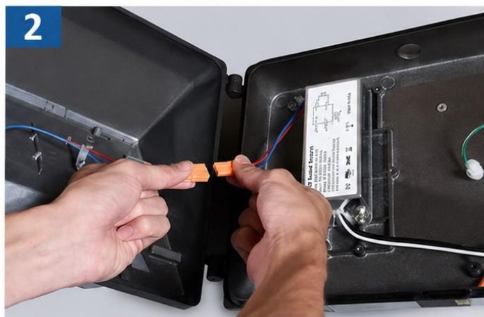
2 Hang de behuizing aan de scharnieren en maak de elektrische verbinding.
