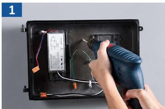
1 Open de armatuur, monteer de achterplaat op de aansluitdoos of muur.
